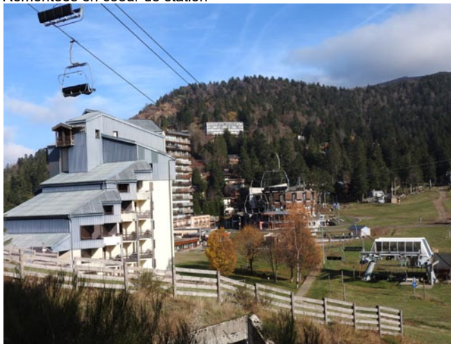
Remontées en coeur de station
