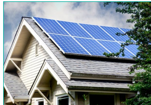
Panneaux photovoltaïques en surimposition ©EDF
