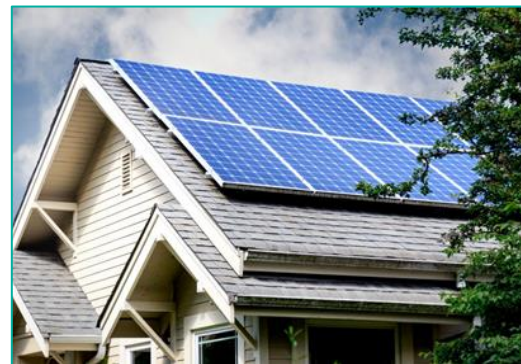
Panneaux photovoltaïques en surimposition © EDF
