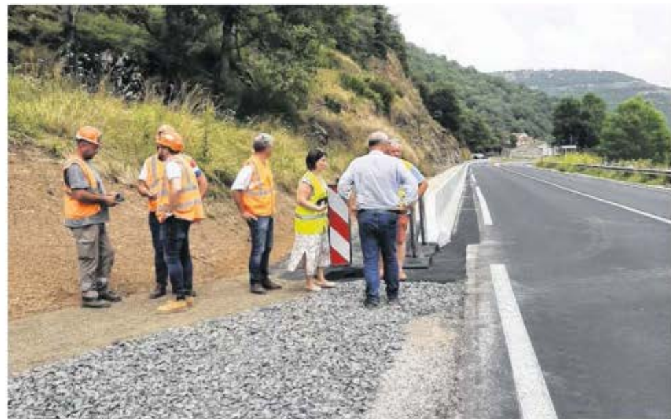
Lors de la visite de chantier qui a eu lieu récemment.
