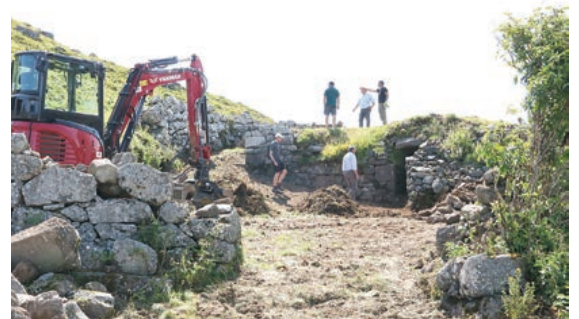
La première phase "maçonnerie" devrait s'achever fin septembre.
