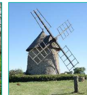
Moulin à vent, Celoux
