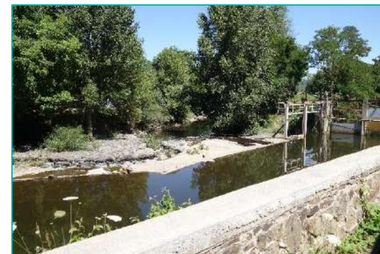
Béal et aménagements divers sur la rivière Alagnon © E.GUIVARC'H
