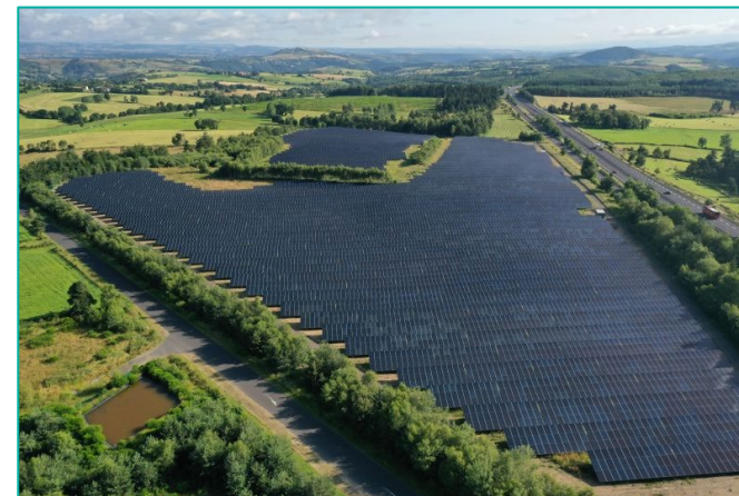
Centrale photovoltaïque de Saint-Mary-le-Plain © Hautes Terres Communauté
