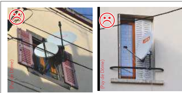
À éviter absolument : la parabole en façade !
