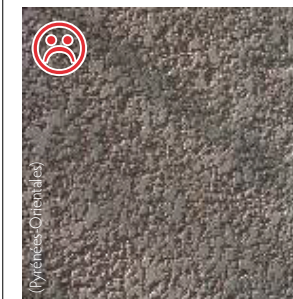
Assez bon exemple d'enduit à l'imitation des enduits anciens de type traditionnel : détournage régulier des ouvertures, teinte très claire façon chaux, suivi des irrégularités de la façade, grain fin (dans une ZPPAUP).
