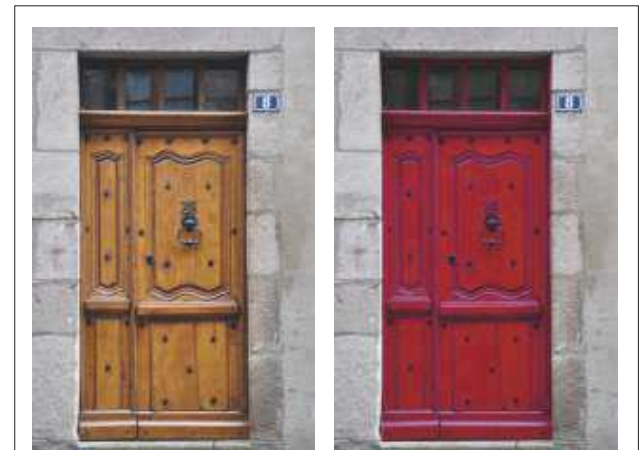
Les portes anciennes peuvent être traitées soit en teinte bois, soit en brun-rouge plus ou moins soutenu.
