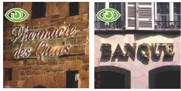
Les enseignes de façade réalisées à l'aide de lettres séparées conservent ainsi l'unité des parements de ces façades.
