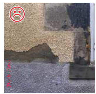
De très nombreux joints à base de ciment ont été réalisés autour des années 1900. Outre leur aspect inesthétique, ils peuvent amener des dégradations des maçonneries. (Tous les exemples dans le Cantal)
