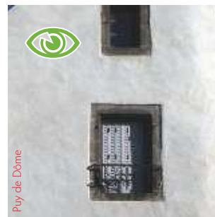
Assez bon exemple d'enduit à l'imitation des enduits anciens de type traditionnel : détournage régulier des ouvertures, teinte très claire façon chaux, suivi des irrégularités de la façade, grain fin (dans une ZPPAUP).
