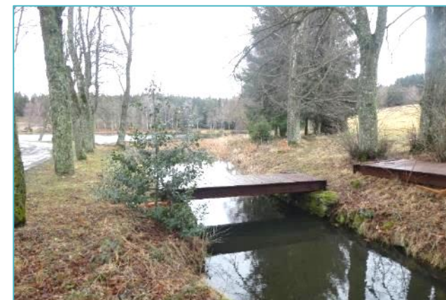
Passerelle enjambant l'étang au Nord ©CAMPUS
