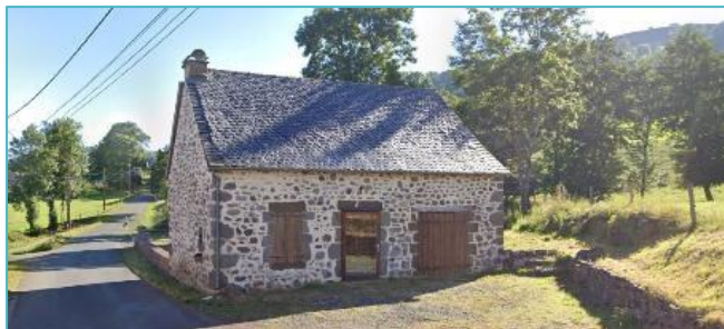
Habitation localisée au Nord-Est de la zone constructible
