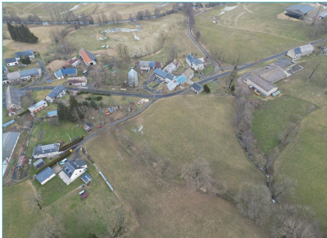
Prise de vue aérienne de zone constructible et de son environnement immédiat ©CAMPUS
