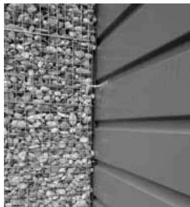
Association de gabions et bardage métallique sur façade
