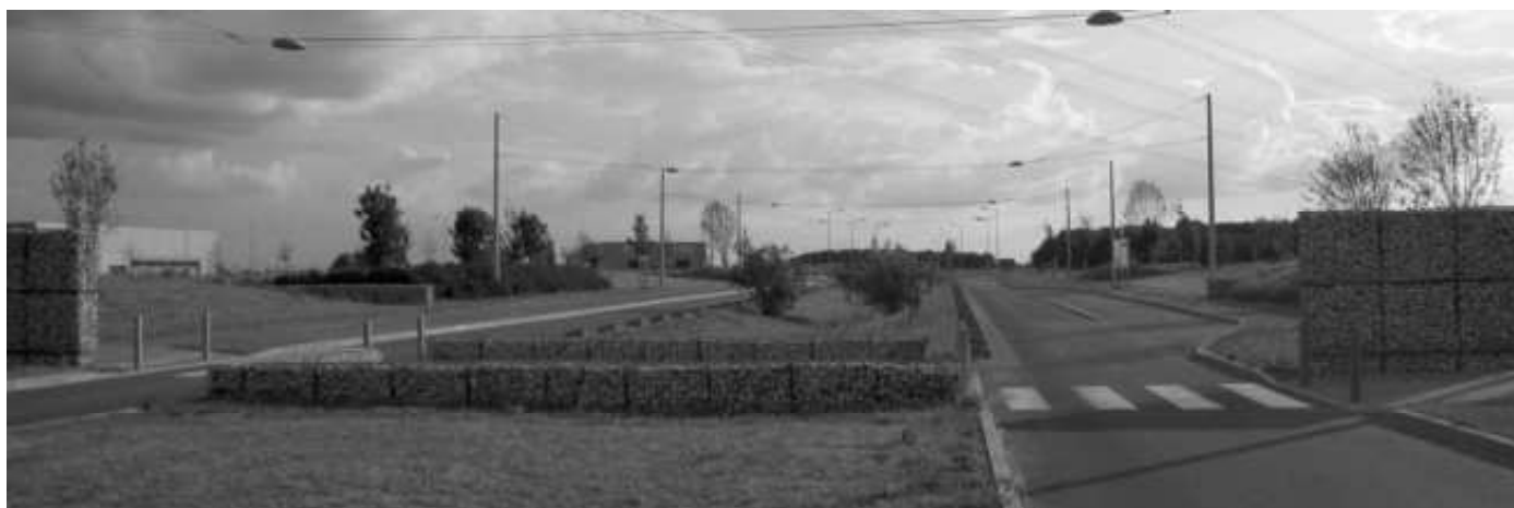
Exemple de murets de gabions pouvant servir d'entrée de lot et d'intégration d'éléments techniques, (Ballan-miré 37).
