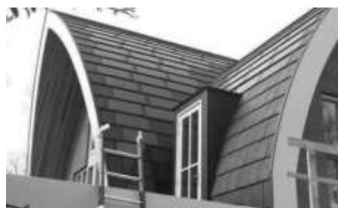
Exemples d'intégration de tuiles ou ardoises photovoltaïques
