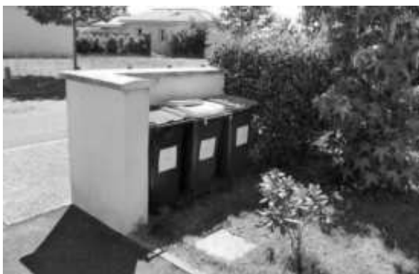
Exemple de muret permettant l'intégration de coffrets techniques et espace conteneurs
