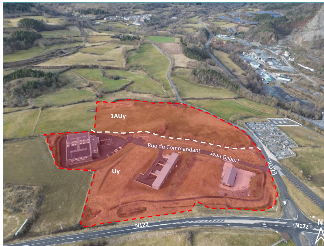
Prise de vue aérienne du secteur "Les Canals" - © Campus Développement
