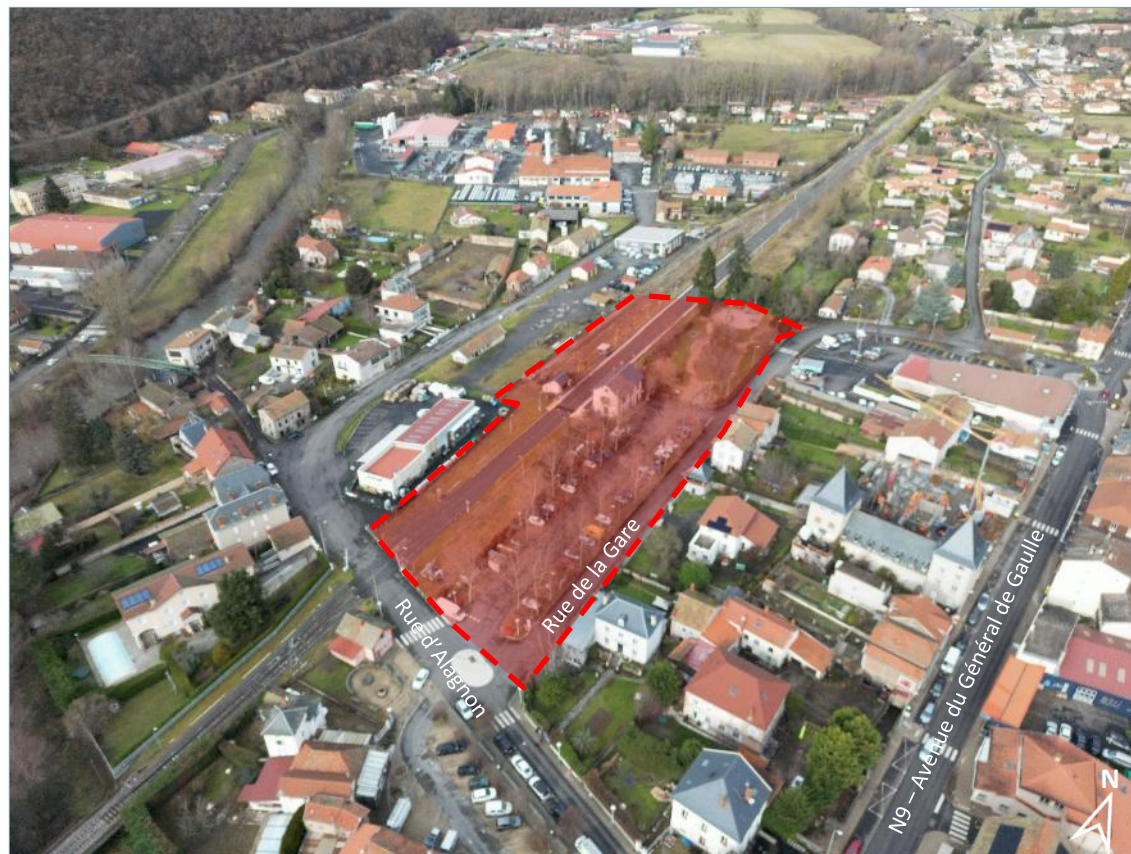
Prise de vue aérienne du secteur de la Gare de Massiac - © Campus Développement
