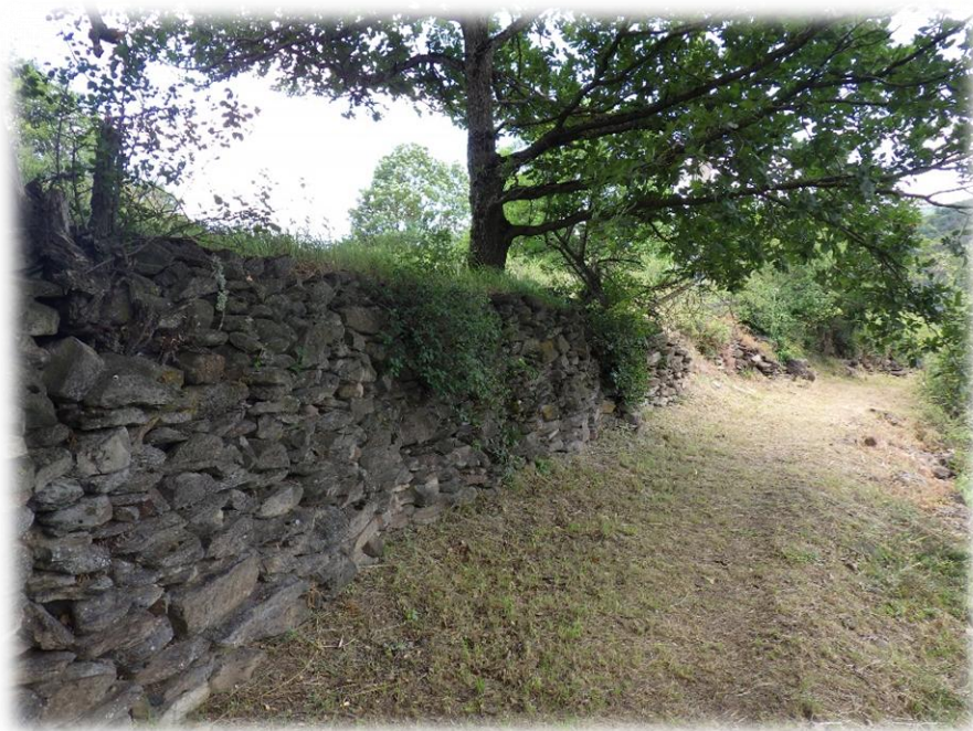
Exemple de muret en pierre sur la commune de Massiac
